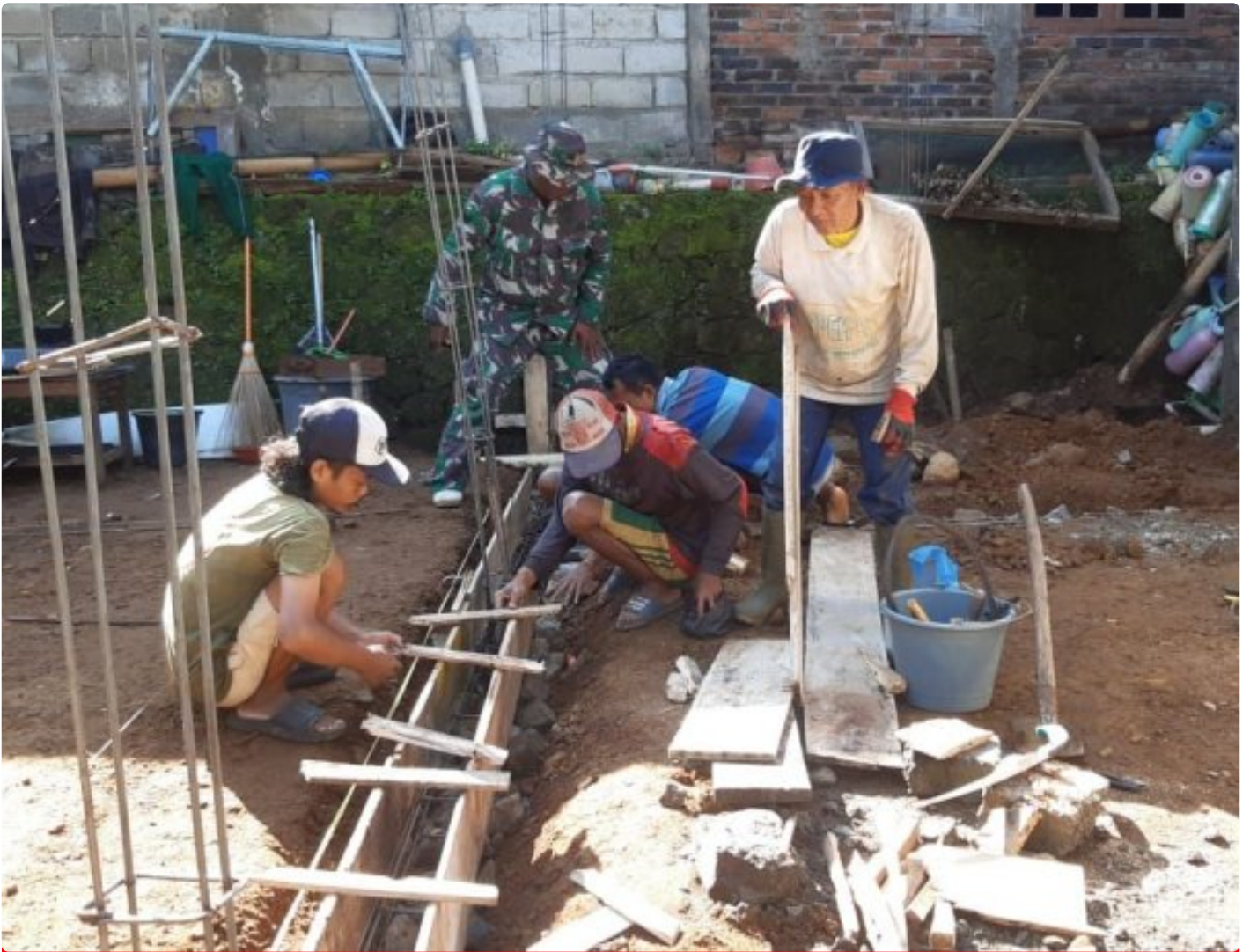
Pemasangan Bekisting Balok Sloof
