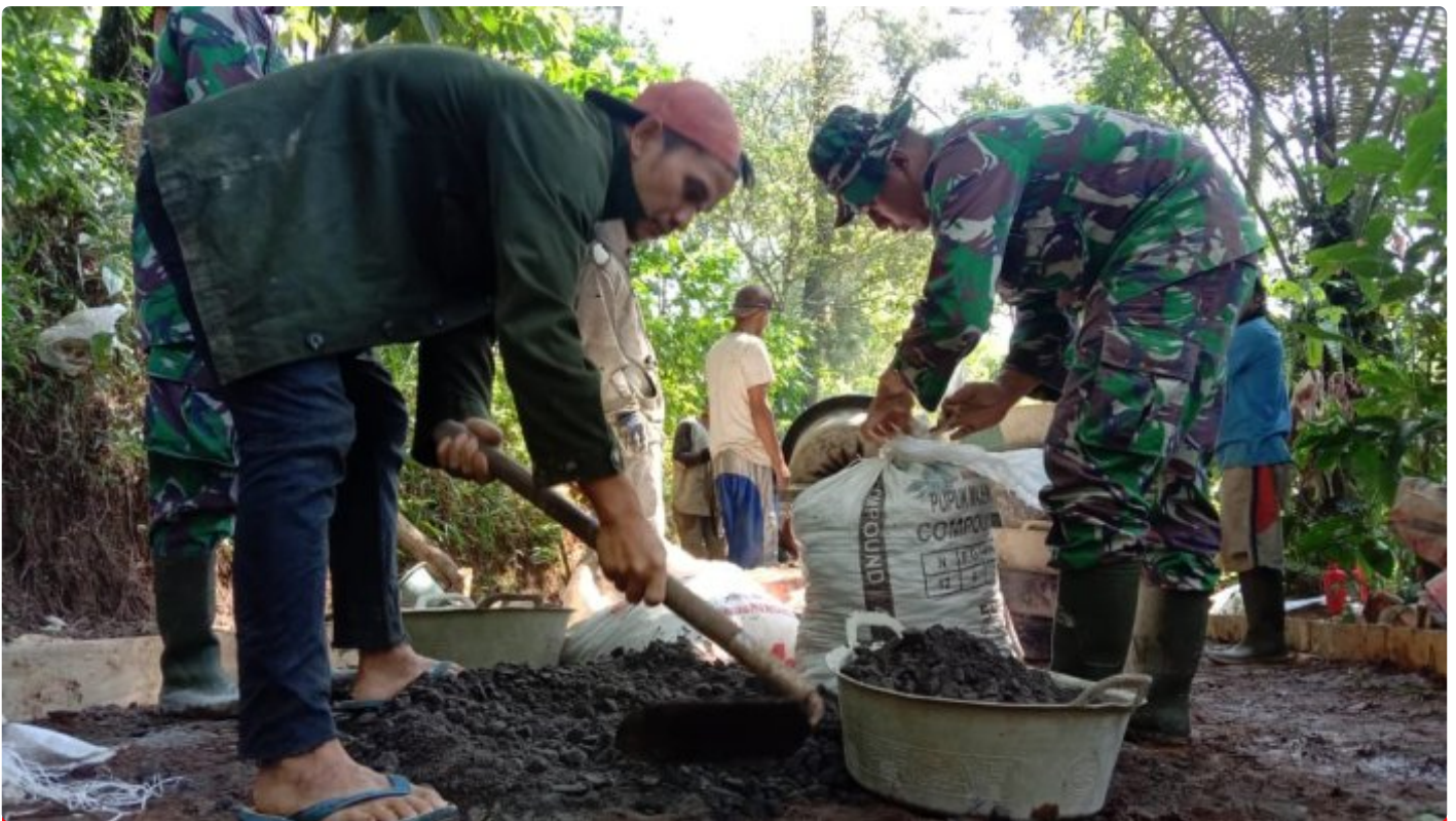
Satgas TMMD dan Warga Bahu Membahu Kebut Pengecoran Jalan
