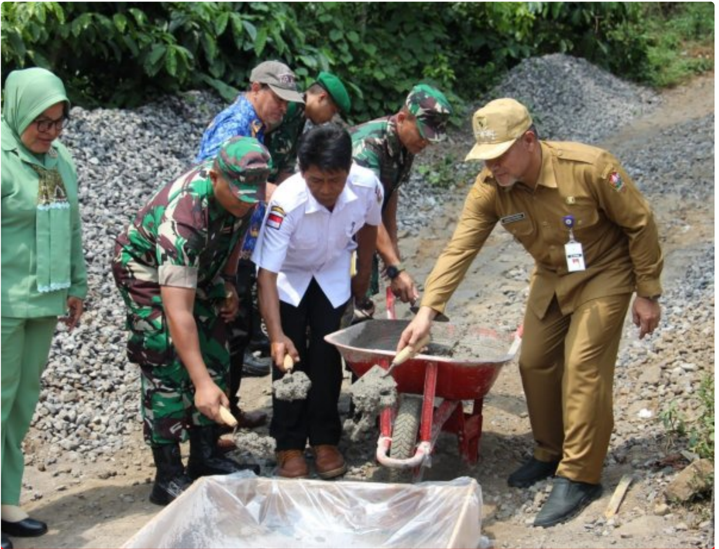
Simbolis Pengecoran Pertama Betonisasi
