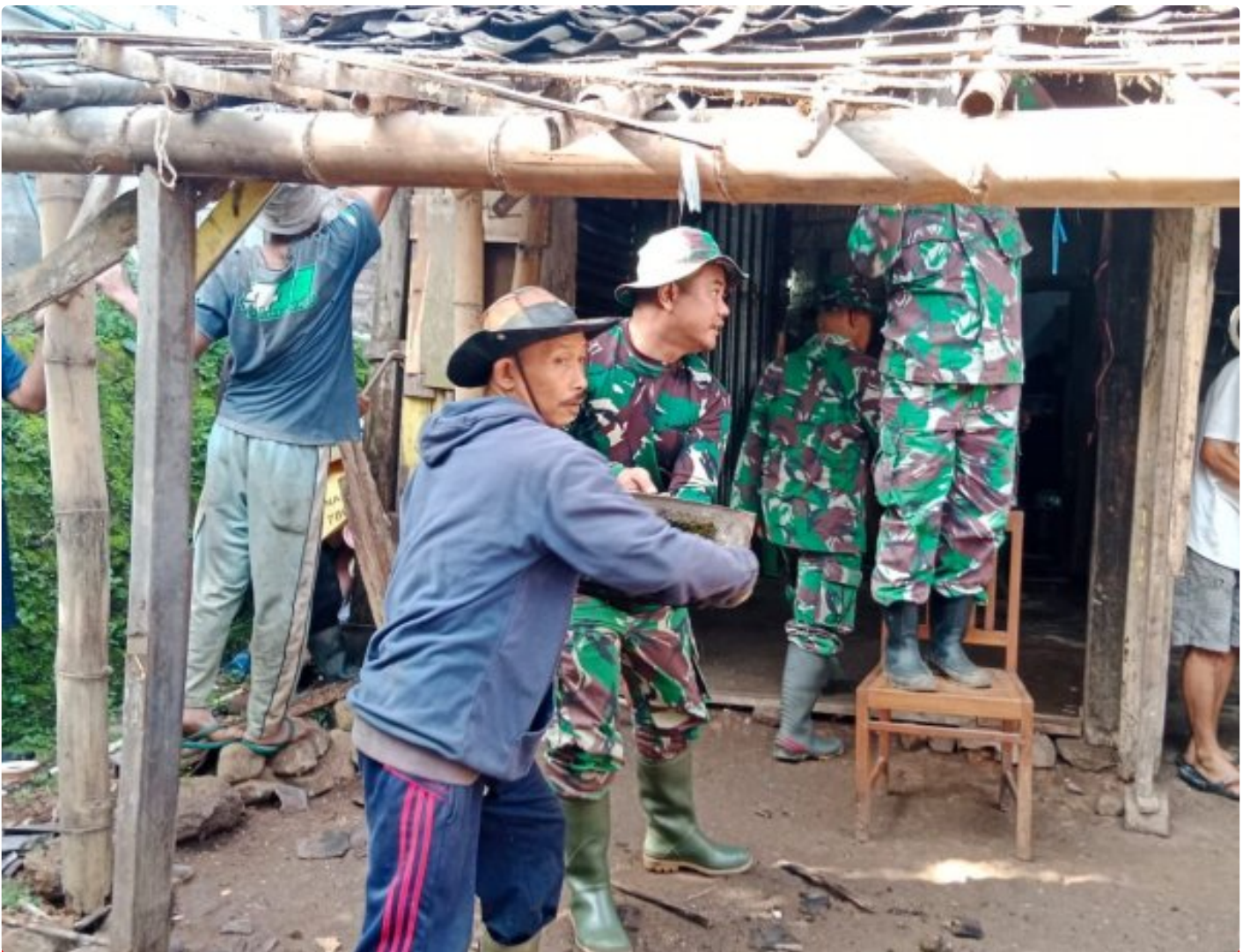
Pembongkar Rumah Sasaran RTLH
