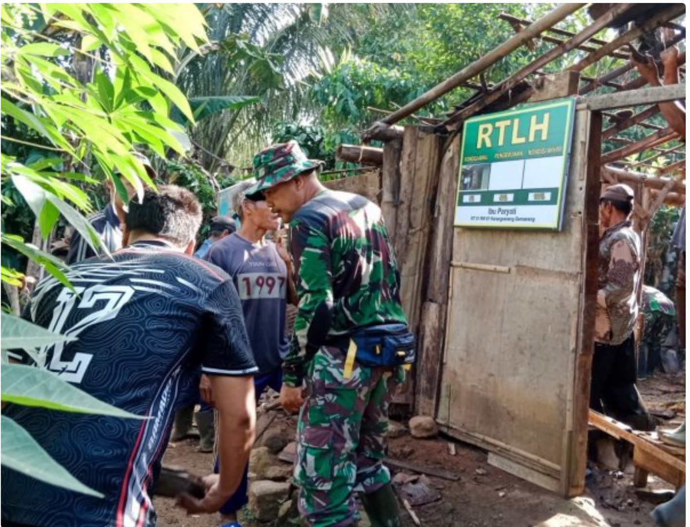
Desa Karangseneng Bahu-Membahu Menyelesaikan 2 Unit Rumah Tidak Layak Huni (RTLH)
